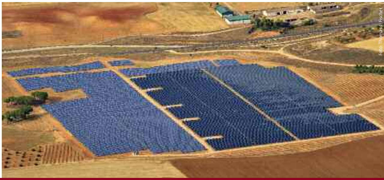
Photovoltaikanlage in Villanueva de la Jara (Spanien), im Bestand des KGAL-Fonds „InfraClass Energie 4“
